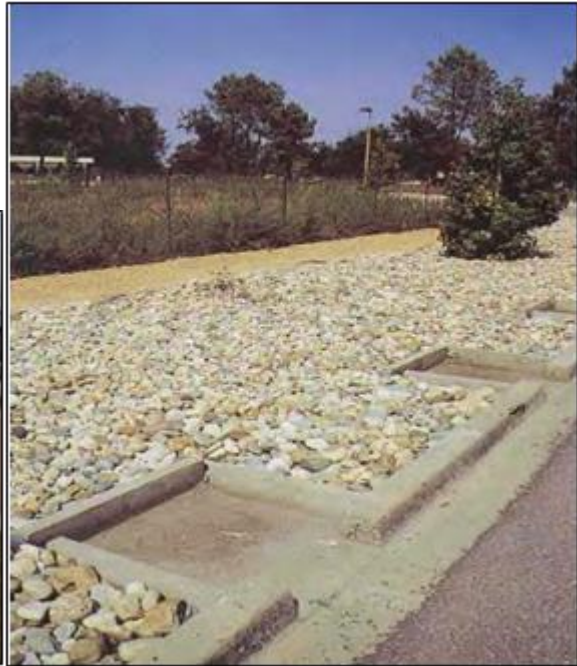
Tranchée d'infiltration le long d'une voirie
